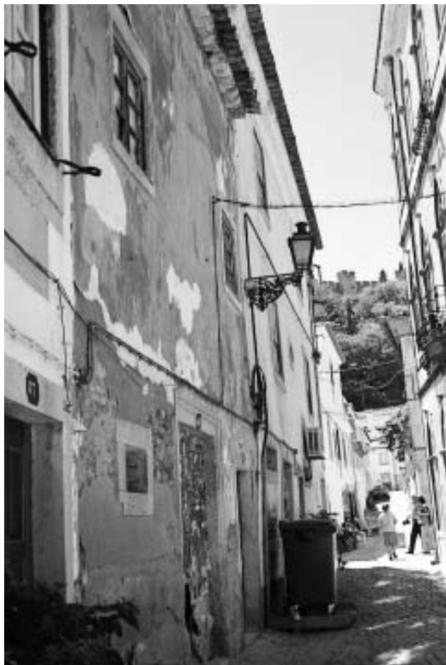
Fig. 1 Edifício 89/91 da antiga rua da Esnoga (Tomar).
